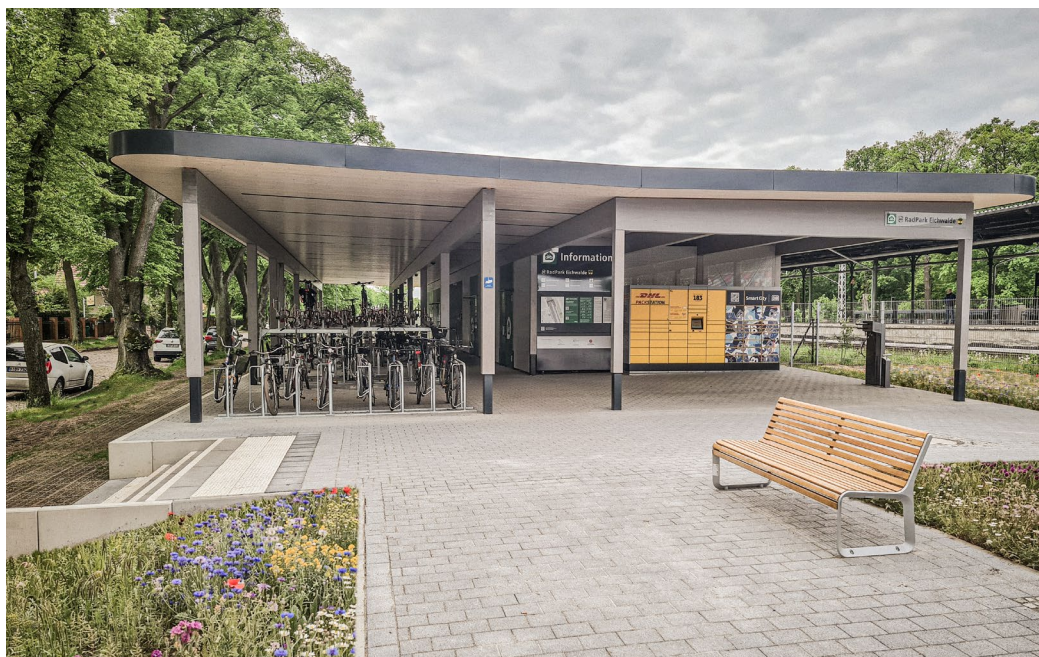
Holzbaueise, digitale Zugangssysteme, Grün- und PV-Dächer, Schließfächer, Radreparaturstation und Paketbox prägen das RadPark-Projekt in Eichwalde
