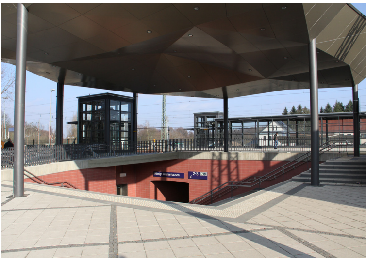
Die große Treppe verbindet den Vorplatz mit dem Hausbahnsteig und der Unterführung
