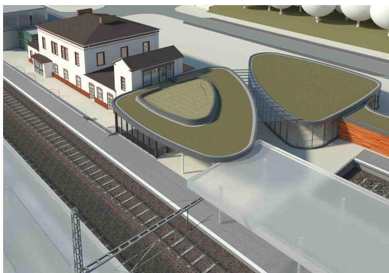
Das Dach über dem Zugang zur Personenunterführung verbindet Alt und Neu
